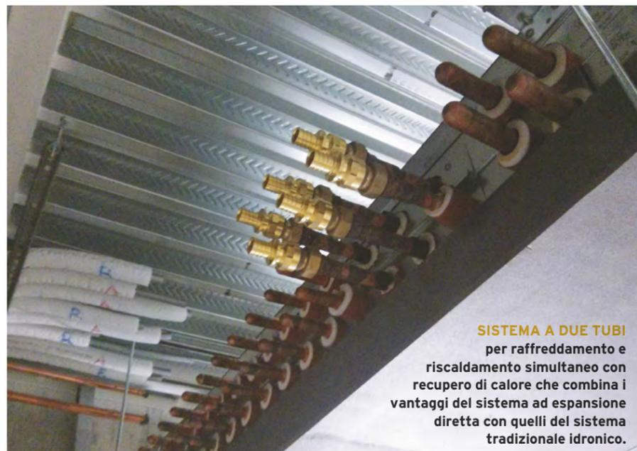
**SISTEMA A DUE TUBI** per raffreddamento e riscaldamento simultaneo con recupero di calore che combina i vantaggi del sistema ad espansione diretta con quelli del sistema tradizionale idronico.
