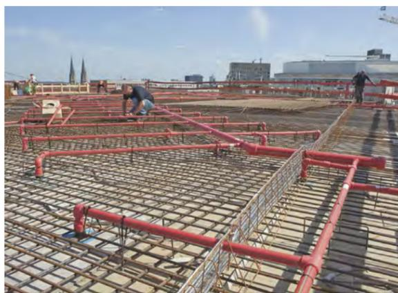
**L'INSTALLAZIONE.** aquatherm red pipe è stato installato nel soffitto dei tre piani del Kö-Bogen, per cui le tubazioni sono state posate nel calcestruzzo.
