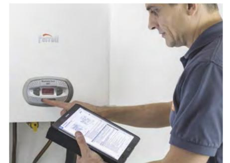
L'INSTALLATORE ha il lavoro semplificato, anche il cambio di gas iniziale, da Metano a GPL, è possibile senza kit ugelli aggiuntivi, senza sforzo ed in pochissimo tempo dai parametri della caldaia.
