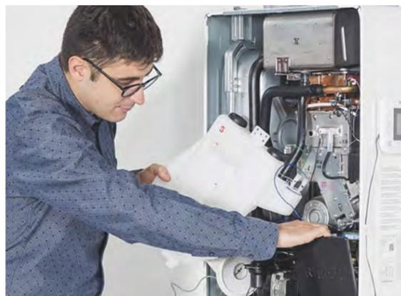
**2. SPOSTARE** il sifone raccogli-condensa integrato nella caldaia per accedere al pannello in cui è posizionato il connettore elettrico che collega il comando remoto standard alla caldaia.
