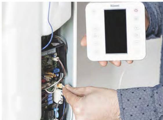
**7. IL CAVO** del suo connettore viene collegato nella caldaia.
