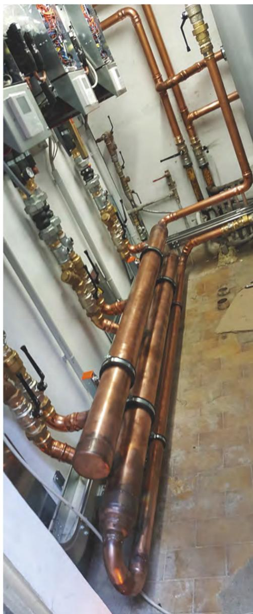
APPLICAZIONE modulare di 3 sistemi Splittati Yutaki-S da 10 HP, per la riqualificazione tecnologica di una vecchia centrale termica di una palazzina uffici.
