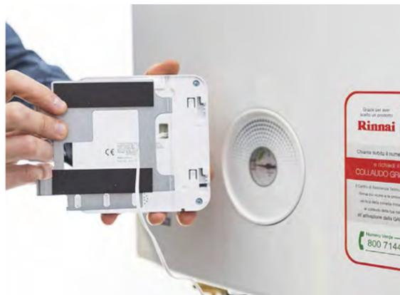
**8. COME** per il comando standard, il controllo Wi-Fi è fornito di maschera di fissaggio.
