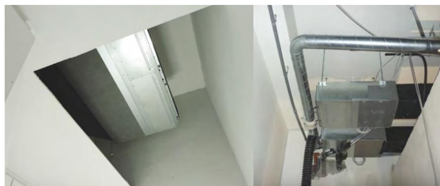
IL BLOCCO VENTILATORE (condensatore remoto) è costituito da un'unità canalizzata da controsoffitto ad alta prevalenza.
