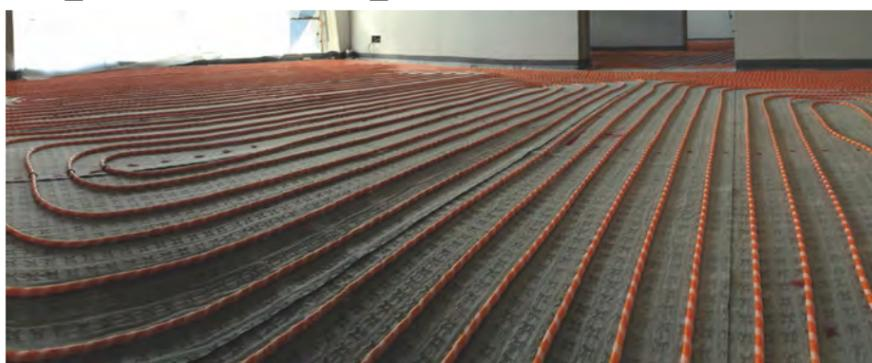
Grazie ai tempi di posa ridotti del 30% rispetto ai tradizionali sistemi, il pavimento radiante adottato ha consentito di terminare i lavori per il nuovo impianto di riscaldamento della scuola/asilo di Pergine Valsugana (TN) prima della scadenza programmata. ■ pag 76
