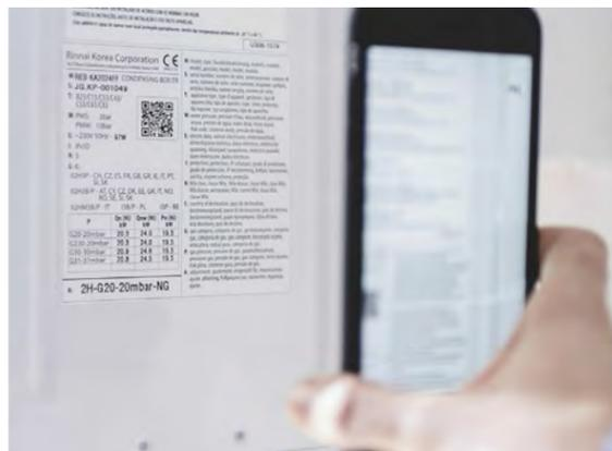
**14. SI SCANNERIZZA** il QR CODE riportato sull'etichetta applicata sul fianco della caldaia e si collega il Wi-Fi alla APP selezionando la rete nelle impostazioni del proprio cellulare.
