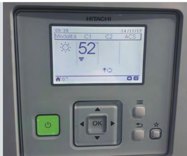
IL PANNELLO LCD di controllo fornito a corredo con il sistema Yutaki S può essere facilmente programmato come cronotermostato ambiente per un controllo climatico intelligente.
