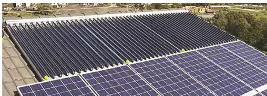
**I PANNELLI SOLARI** sottovuoto Aqua Plasma utilizzano semplice acqua come fluido termovettore al posto delle tradizionali miscele acquaglicole.
