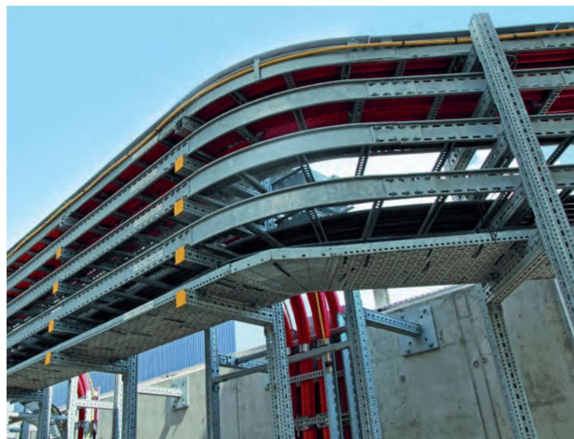
IL SISTEMA di staffaggio brevettato SiFramo si propone come alternativa alle classiche travi in ferro tipo IPE, HEA, ecc, andando a eliminare il costo e i tempi che richiedono la saldatura.
