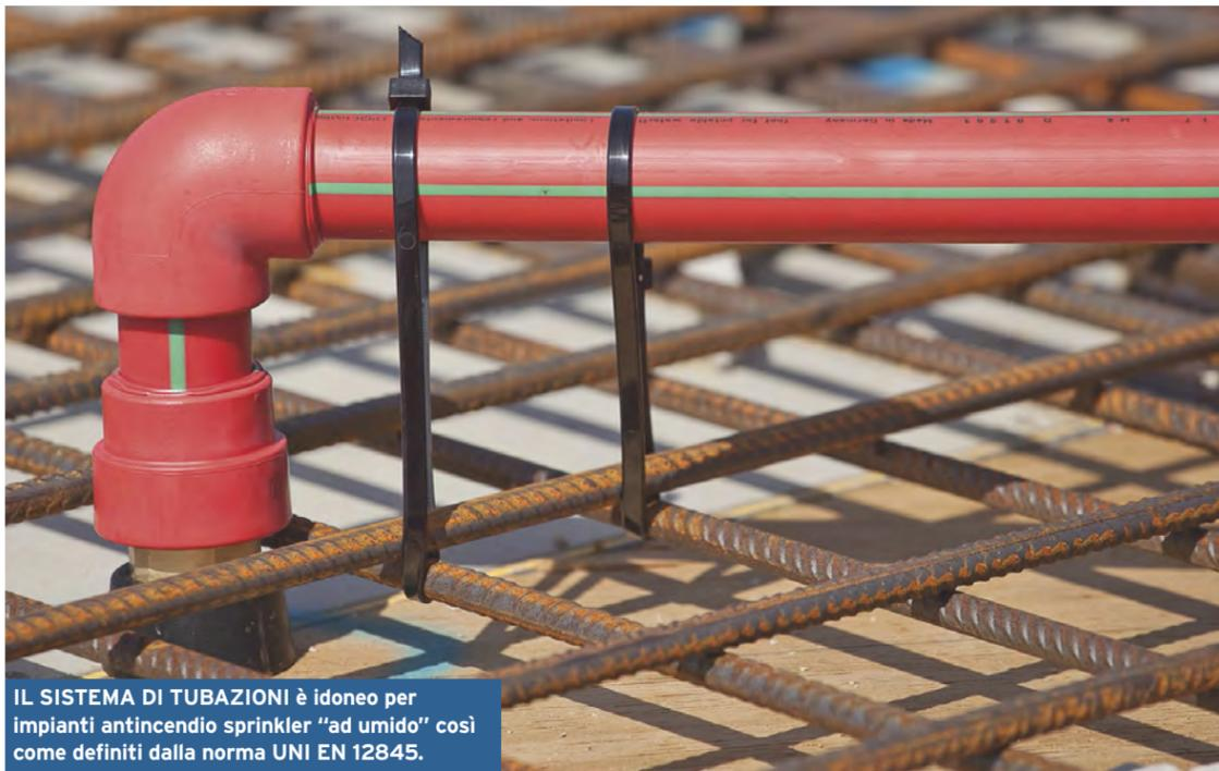
IL SISTEMA DI TUBAZIONI è idoneo per impianti antincendio sprinkler "ad umido" così come definiti dalla norma UNI EN 12845.
