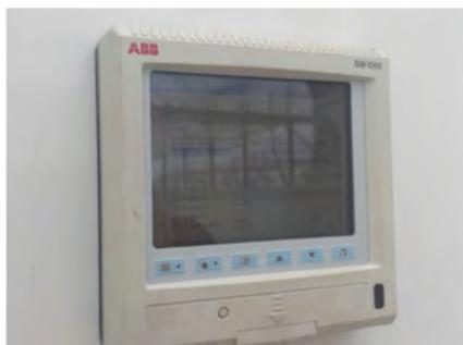
**IL SISTEMA DI MONITORAGGIO** calcola in tempo reale il COP delle diverse macchine in attività, in modo da regolare il funzionamento dell'intero impianto secondo criteri di efficienza e convenienza economica.
