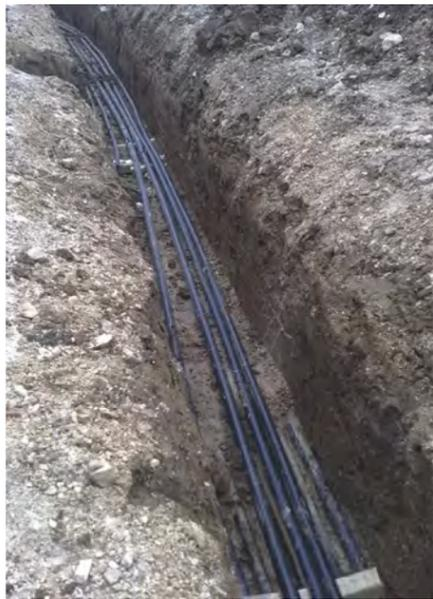
**LE TUBAZIONI** di diametro crescente che collegano le sonde si sviluppano nel sottosuolo realizzando una rete con ritorno inverso funzionale al bilanciamento automatico delle portate.
