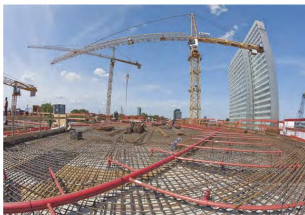
**I NUMERI.** Presso il maestoso e imponente complesso edilizio Kö-Bogen di Düsseldorf sono stati installati circa 6.500 metri di tubazioni, compresi i raccordi e 3.400 connessioni sprinkler.
